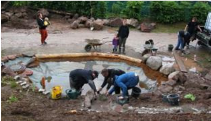
Ehrenamtliche Helfer bauen einen Zulauf für einen neuen Teich.
